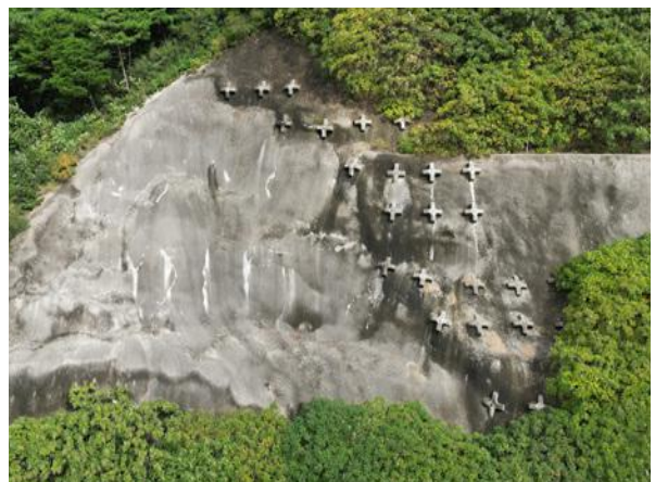
쑈크리트, 격자블럭 전경
