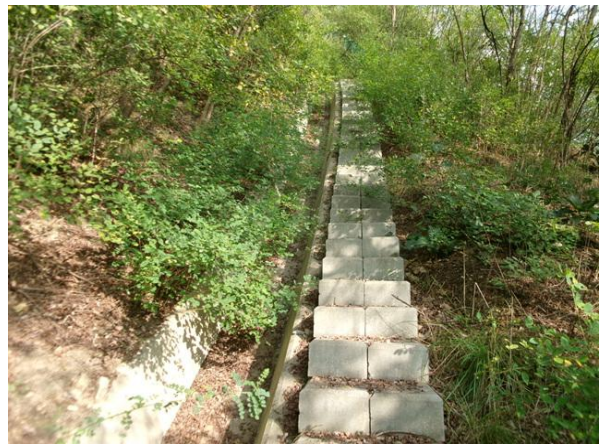
산마루측구, 점검계단 전경
