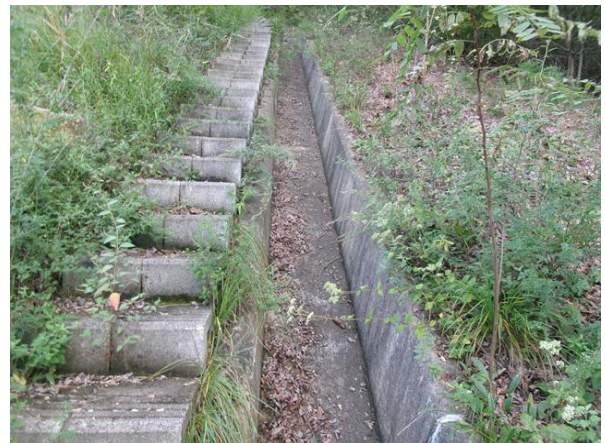
점검계단, 산마루측구 전경
