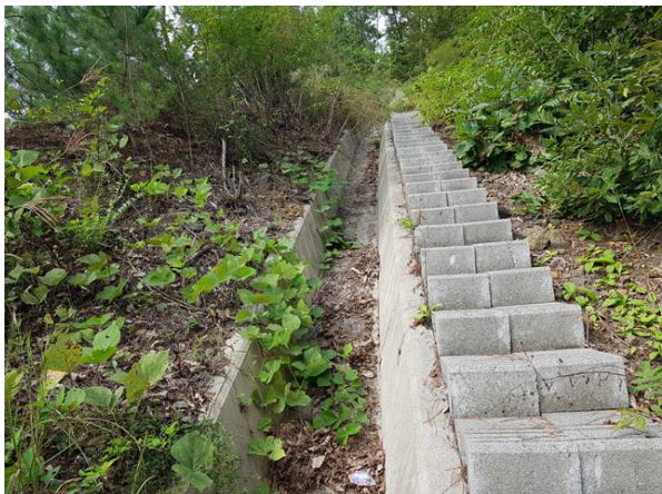
점검계단, 산마루측구 전경
