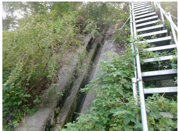
수직도수로, 점검사다리 전경
