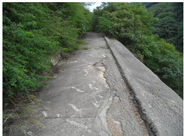
1소단 배수로 전경
