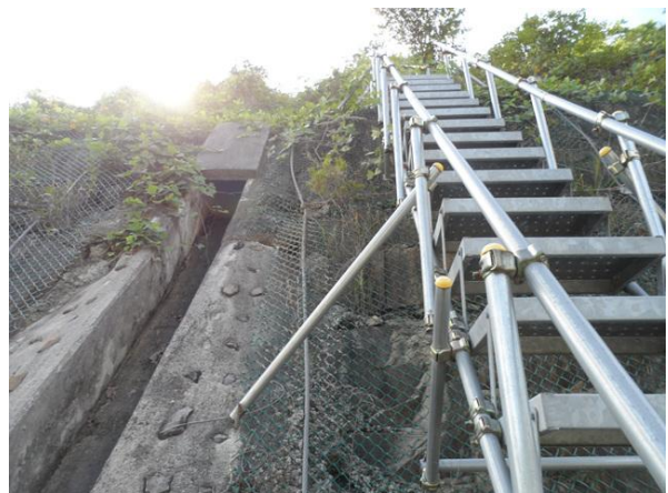
수직도수로, 점검계단 전경
