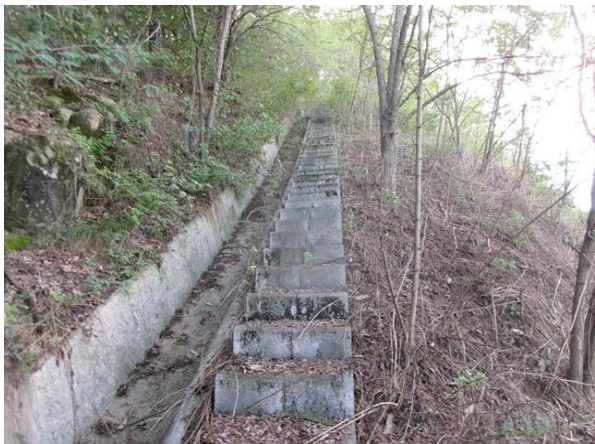
산마루측구, 점검계단 전경
