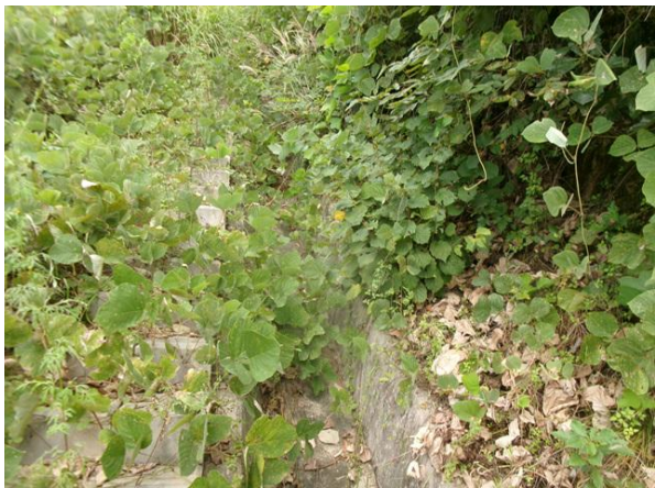
산마루측구, 점검계단 전경
