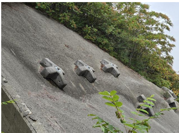
쑈크리트, 격자블럭 전경
