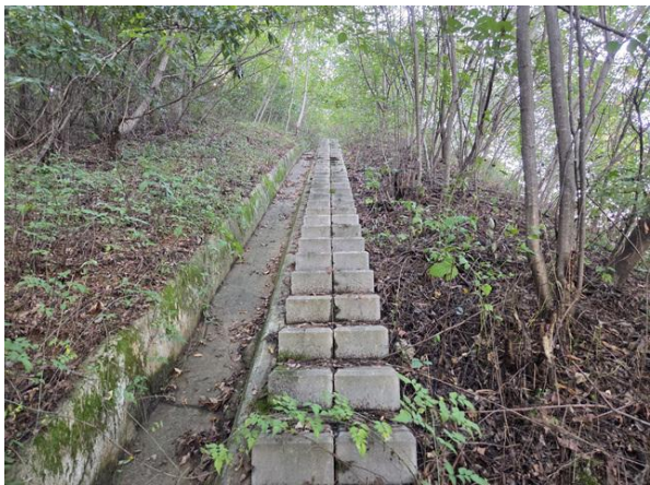
산마루측구, 점검계단 전경
