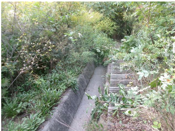
산마루측구, 점검계단 전경
